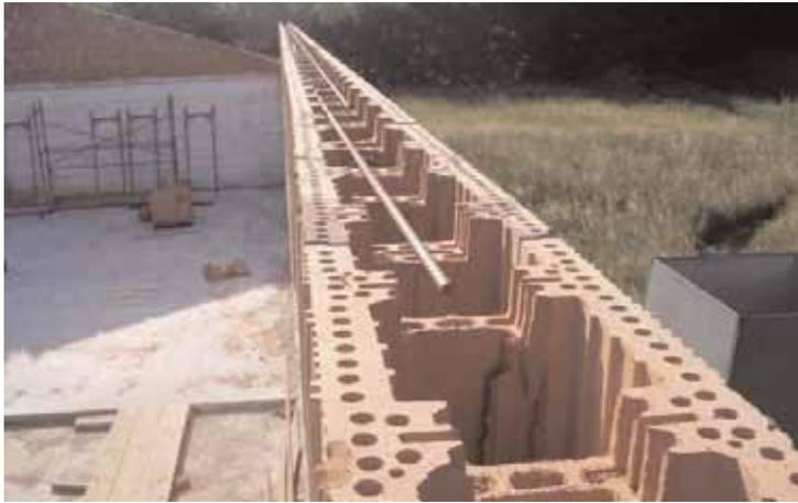
Oft ist aus statischen Gründen die Ausbildung von Säulen und Umschließungsrosten erforderlich. Bisher musste hier viel Arbeitszeit in aufwändige Schalungsarbeit investiert werden. Mit dem neuen POROTHERM SBZ.i Plan wird die Schalung zeitsparend mitgemauert; Bewehrung und Beton kann nach statischen Erfordernissen eingebracht werden und es entsteht gleichzeitig eine normale Ziegeloberfläche, die einen optimalen Putzgrund darstellt.
