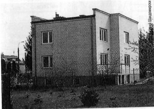
Типовые дома 60-х годов – так называемые дома-кубики – не могут быть теплыми. Когда они строились, сопротивление теплопередаче стен  $R$  не могло быть ниже  $0,71 \text{ м}^2 \cdot \text{К}/\text{Вт}$ . Сейчас после утепления старых домов стена должна иметь сопротивление теплопередаче  $R$  не ниже  $4,0 \text{ м}^2 \cdot \text{К}/\text{Вт}$
