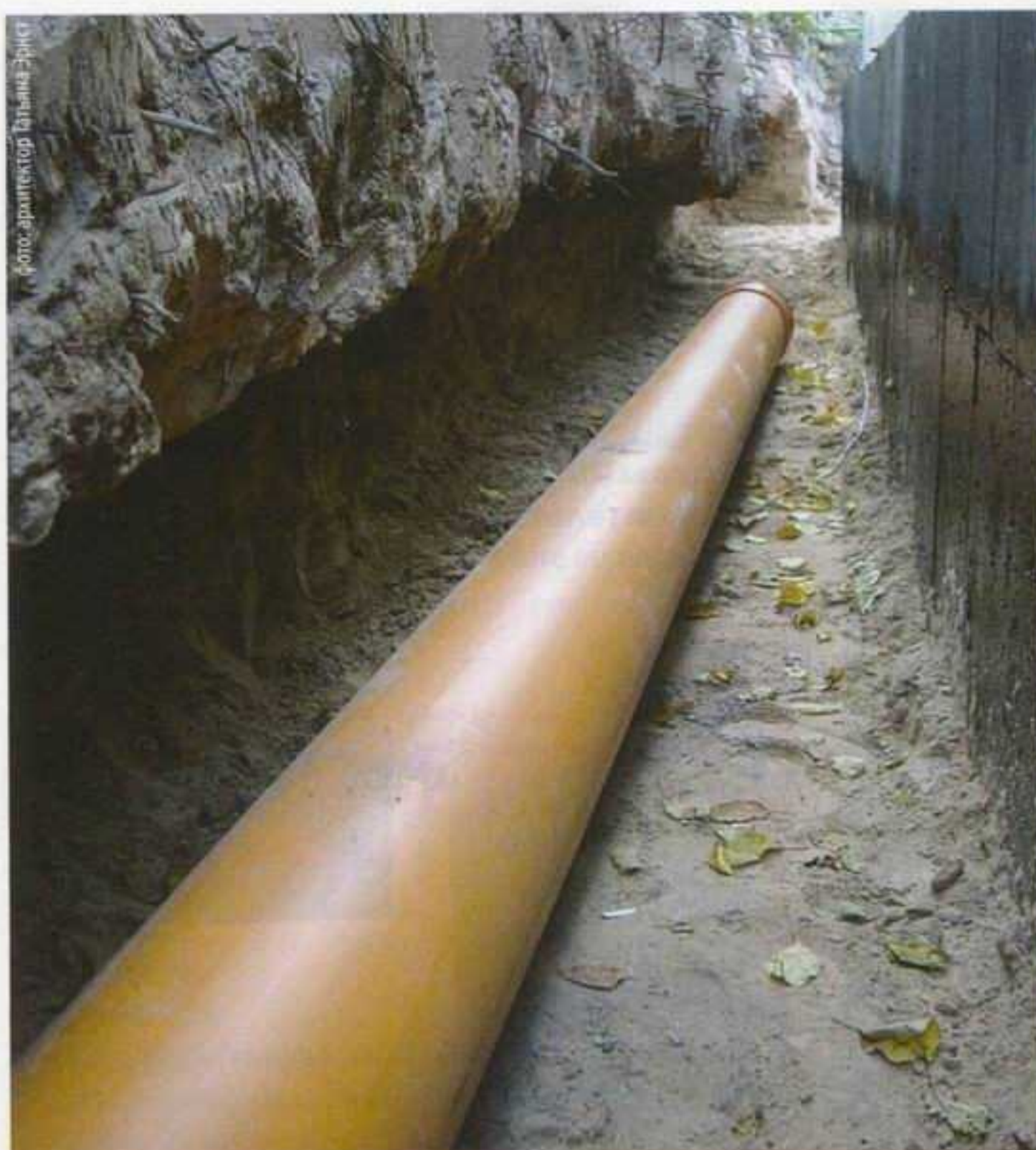
↑ Укладывать теплообменник желательно вблизи дома, так как температура грунта здесь обычно немного выше
