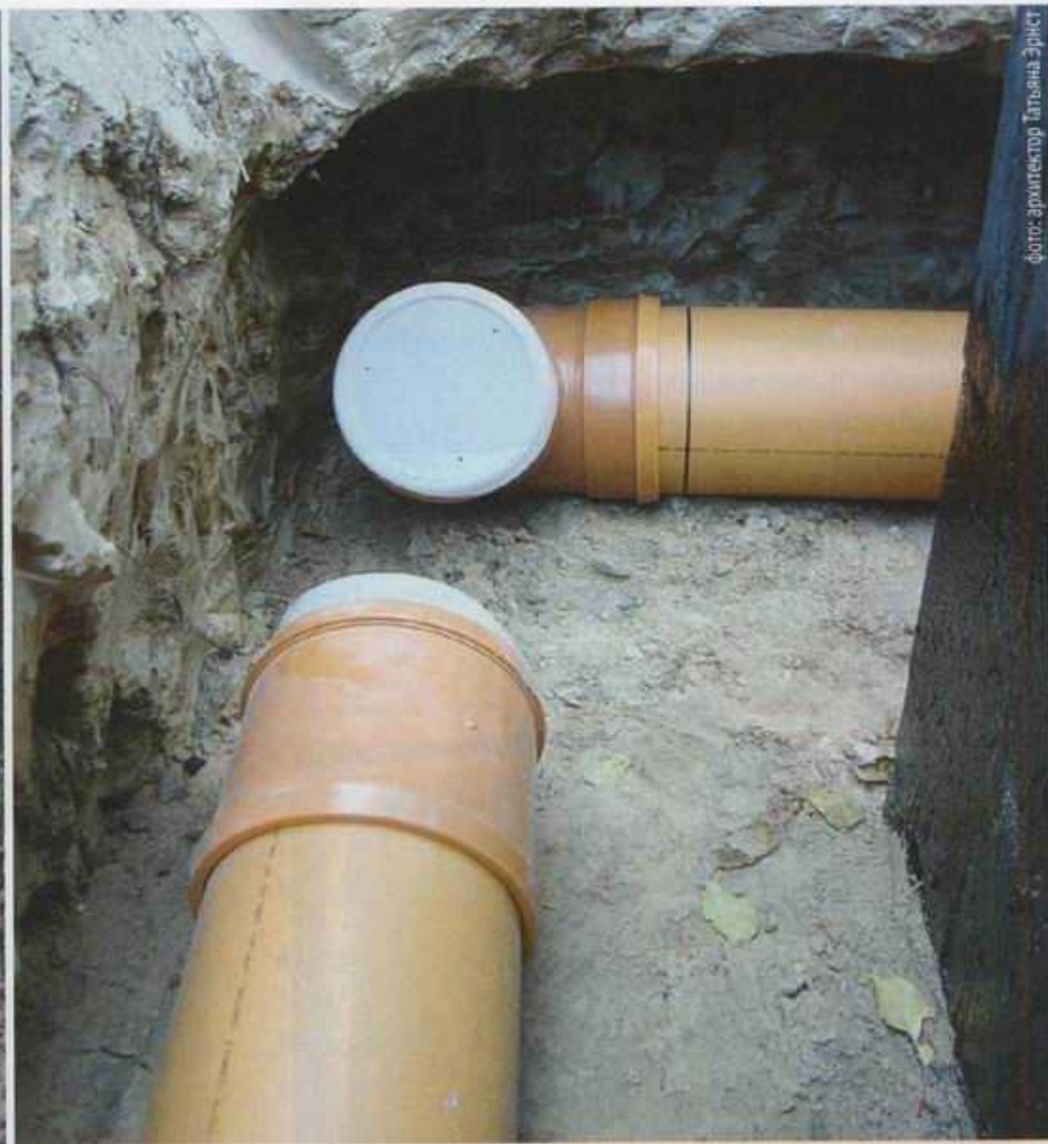
↑ Повороты затрудняют прохождение воздуха по трубе, поэтому их должно быть как можно меньше
