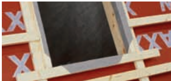
Устройство проёма мансардного окна
