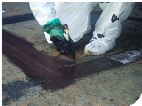
Можно наносить с помощью, кисти, валика или распылительного оборудования. Материал полностью затвердевает в течение 24 часов при температуре 20°C и относительной влажности 50%, при нанесении 1 слоя толщиной 1 мм. Рекомендуется наносить тонкими слоями, давая затвердеть нанесённому слою перед тем, как наносить следующий. Время затвердевания может изменяться в зависимости от температуры и относительной влажности.
