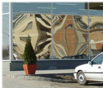
Рисунок 1. Эффект линзы (визуальное искажение стекла из-за прогиба наружного стекла).
