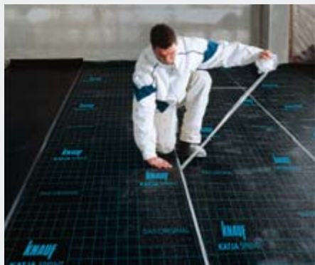
Склеивание продольных стыков после удаления пленки
