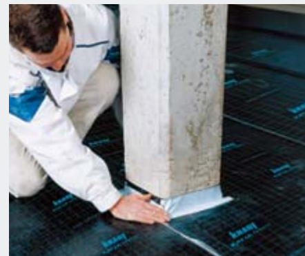
Примыкания к восходящим строительным деталям при помощи полосы для стыков КНАУФ
