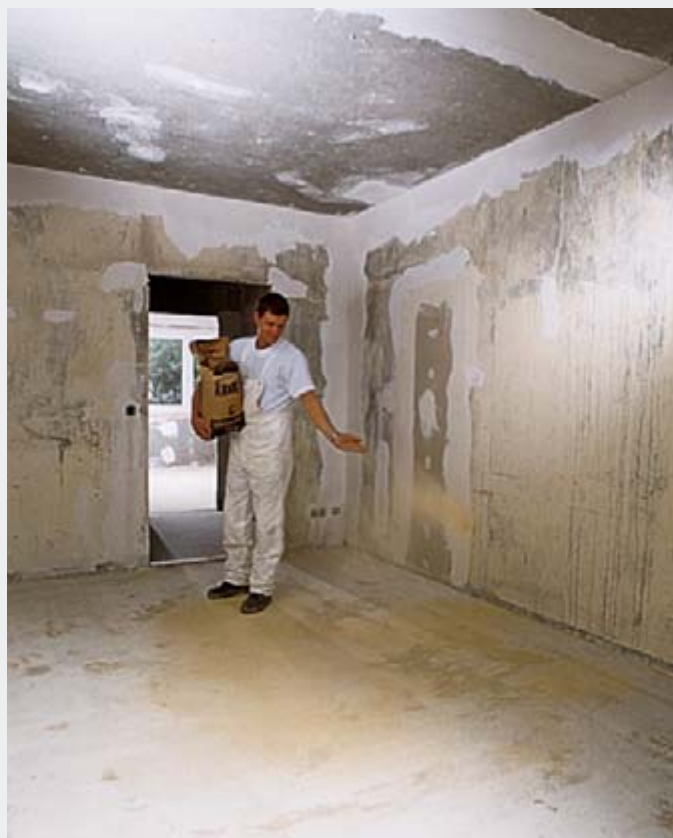
Например, обработка средством для повышения адгезии, с посыпкой кварцевым песком
