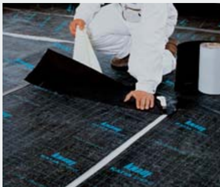
Гидроизоляция торцевых стыков осуществляется при помощи полосы для стыков КНАУФ
