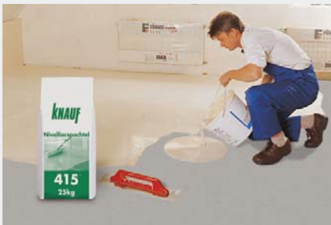
Шпаклевание монолитного пола самовыравнивающейся шпаклевкой КНАУФ Нивелиршпachtель 415
