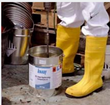
Замешивание эпоксидной смолы мешалкой
