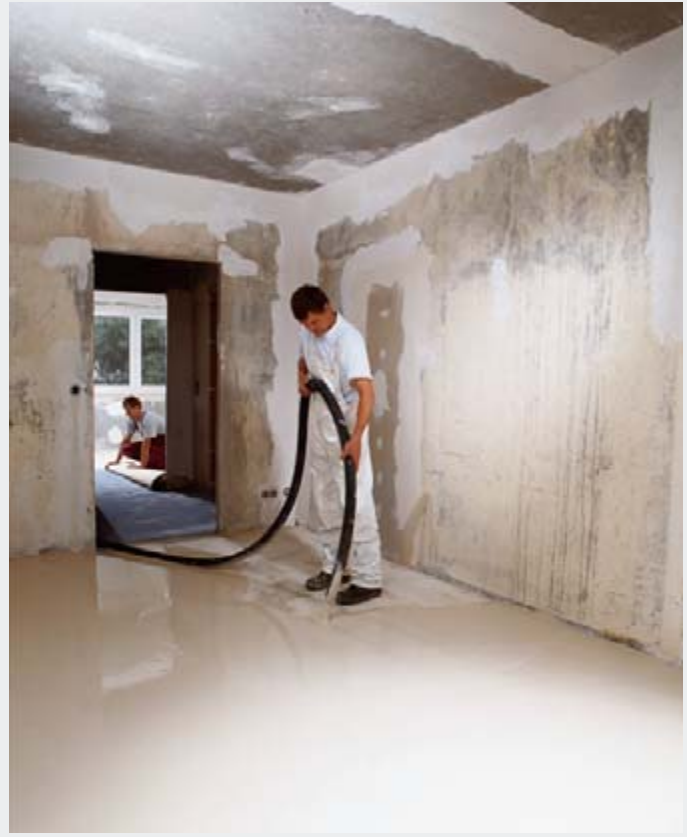
Например, механизированная укладка самовыравнивающегося наливного пола КНАУФ Нивелирэстрих 425
