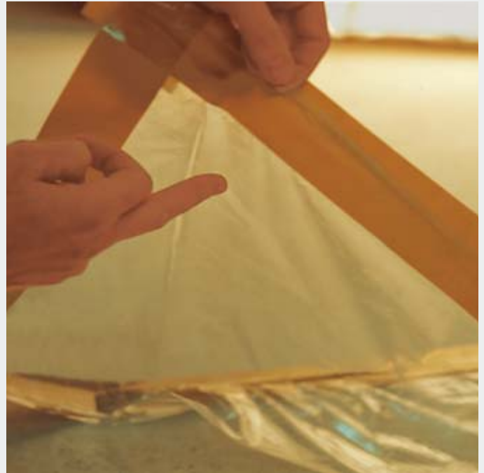
Контроль на образование конденсата под пленкой
