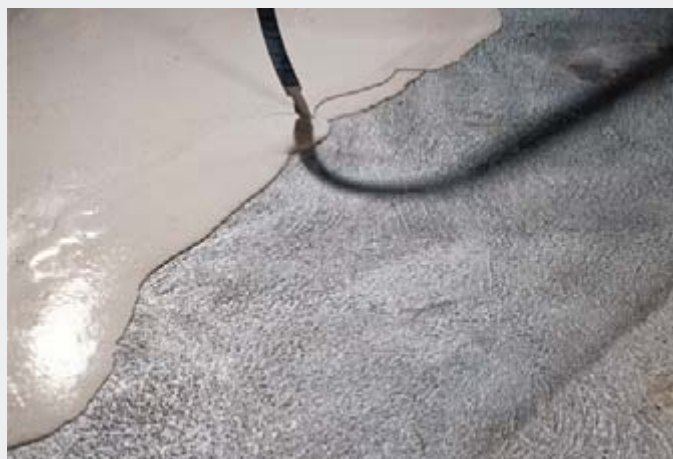
Механизированная укладка самовыравнивающейся шпаклевки КНАУФ Нивелиршпachtель 415
