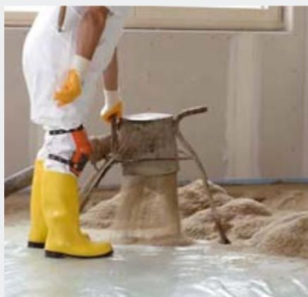
Укладка при помощи пневматического транспортного насоса
