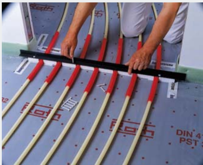
Деформационный шов в теплом монолитном полу, тип конструкции А, на дверном проеме
