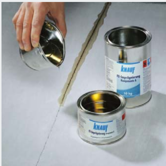
Заливка трещин эпоксидной смолой
