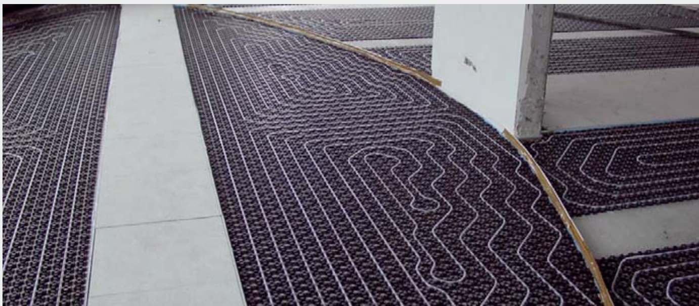
Схема отопления – Тонкослойный монолитный теплый пол с самовыравнивающимся наливным полом КНАУФ Нивелирэстрих 425
