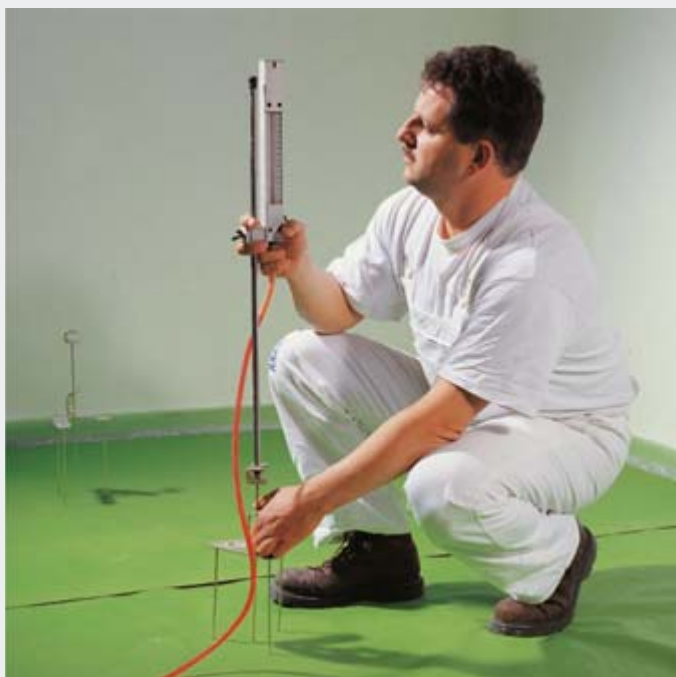
Регулирование высоты при помощи нивелировочного уровня PFT
