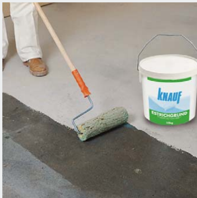
Нанесение грунтовки КНАУФ Эстрихgrund
