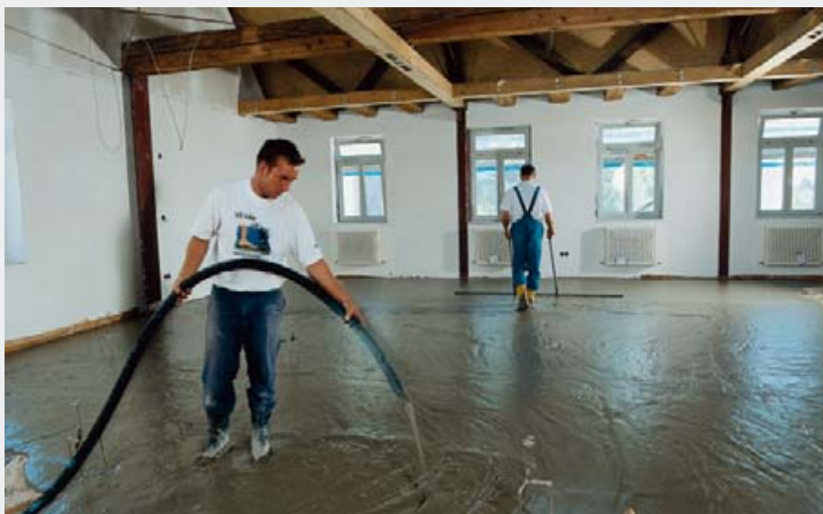
Там, где раньше нужно было затратить много усилий, чтобы закрыть стиропором все полости, сегодня КНАУФ Schubo легко проникает во все пустоты
