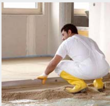
Укладка при помощи пневматического транспортного насоса
