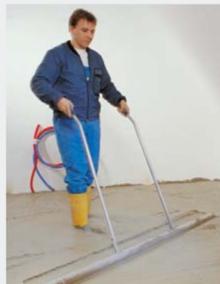
После заливки материала просто выровнять его виброрейкой
