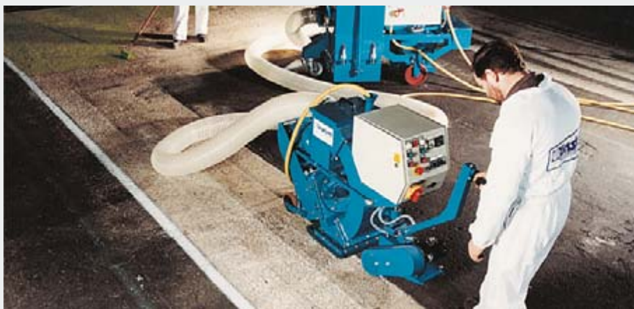
Чистка бетонного пола дробеструем для укладки монолитного сцепленного пола
