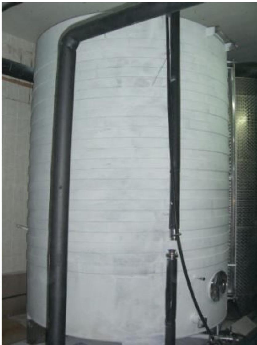
Утепление емкости с жидкостью с отрицательными температурами
