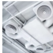
Монтаж систем вентиляции
