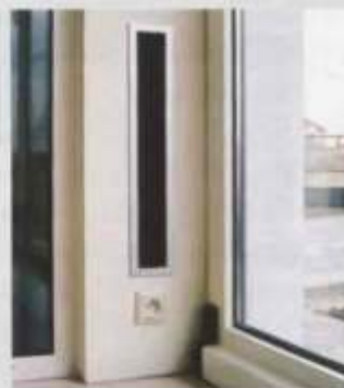
↑ Вентиляционное отверстие, через которое воздух из зимнего сада попадает в пространство между слоями наружной стены
