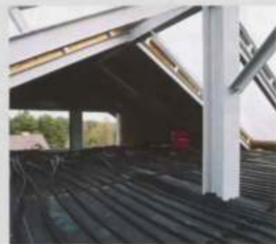
↑ Вентиляционное отверстие на чердаке. Когда слишком жарко, поднимается закрывающая его роллета, что при одновременном открывании окон зимнего сада позволяет воздуху свободно циркулировать
