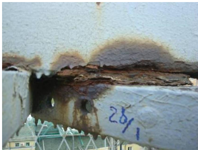
Рисунок. 3.14. – Щелевая коррозия
