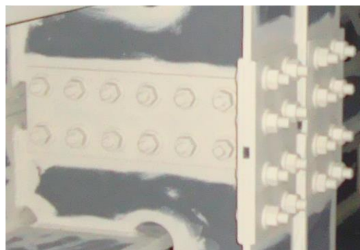
Рисунок 9.6. – Полосовая окраска болтовых соединений.
