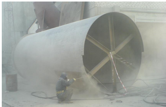
Рисунок 9.76 – Абразивоструйная очистка сжатым воздухом.
