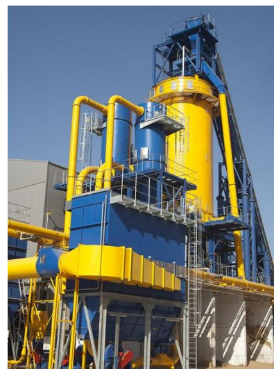
Рисунок 9.4. – Встроенные приспособления для обслуживания сооружения.
