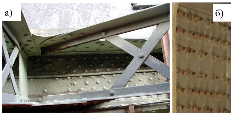
Рисунок 9.5. – Соединения мостовых конструкций: а – заклепочное; б – болтовое.
