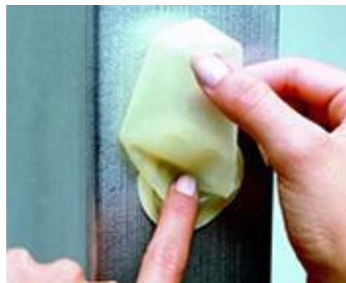
Рисунок 9.41. – Массажирование раствора через рукав.
