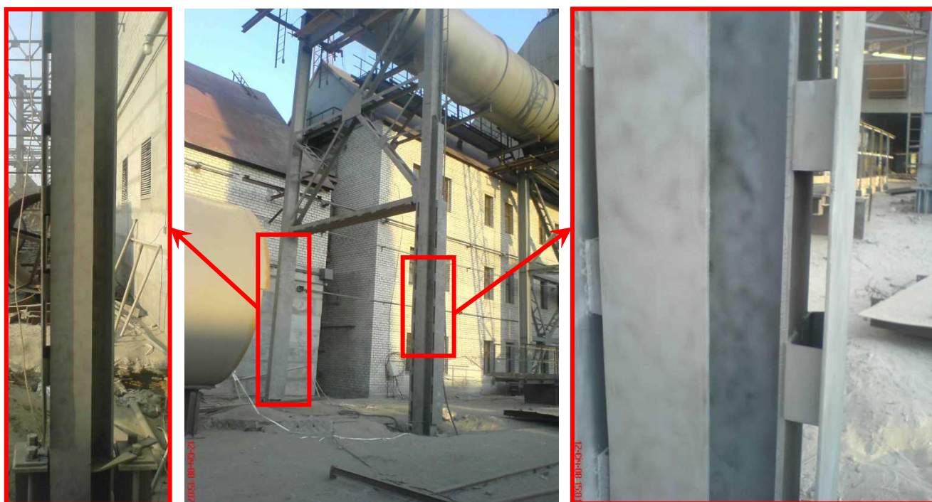
Рисунок 9.1. – Недостаточный зазор между стойкой рамы и усиливающим листом.
