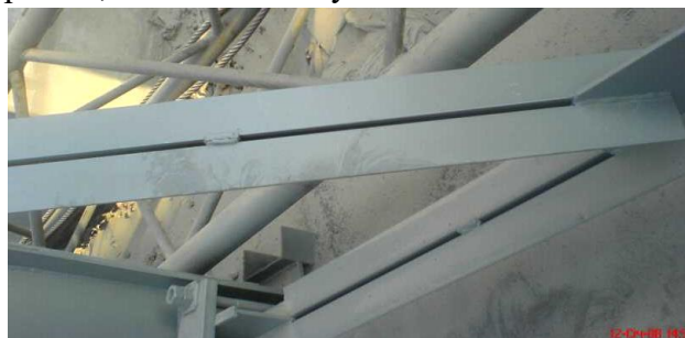
Рисунок 9.10. – Горизонтальные связи, пояса и раскосы фермы выполнены в виде спаренных уголков.
