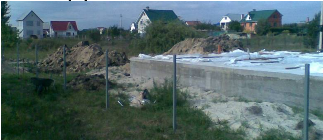
2009-08-01 Снимаем опалубку
