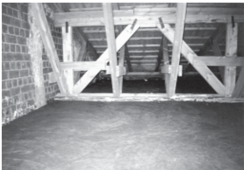
Рис. 4. Участок теплоизоляции чердачного перекрытия с защитной стяжкой
