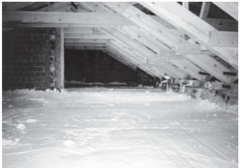
Рис. 3. Участок монолитной укладки теплоизоляционного материала «Поропласт CF 02»
