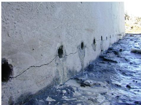
Шпуров необходимо сверлить на глубину, равную толщине разрушаемого элемента. При этом шпуров не должны быть сквозными. При разрушении камней и неармированного бетона расстояние между центрами шпуров должно быть 30-60 см в зависимости от их диаметра. При разрушении железобетона это расстояние должно быть 20-30 см. Правило следующее : чем меньше диаметр шпуров тем меньше должно быть расстояние между ними. К примеру,
